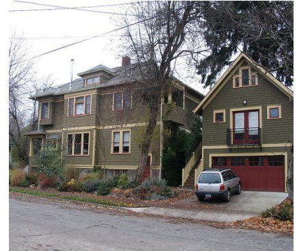
ADU sobre un garaje proporciona desarrollo de relleno en un vecindario existente. Foto: https://accessorydwellings.org/what-adus-are-and-why-people-build-them/ . Consultado el 12 de junio de 2020.
